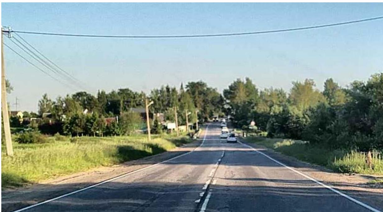
Рисунок 2.6.2.3 – Отсутствует разметка 1.17.1 согласно требованиям ГОСТ Р 52289-2019, а/д 41К-003
