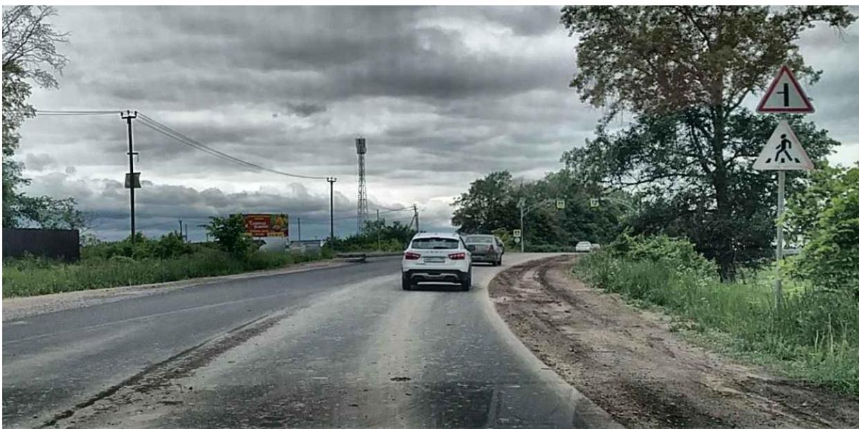
Рисунок 2.6.1.3 – Эксплуатационное состояние знака 1.22 «Пешеходный переход» не соответствует требованиям ГОСТ Р 50597-2017, а/д 41К-010
