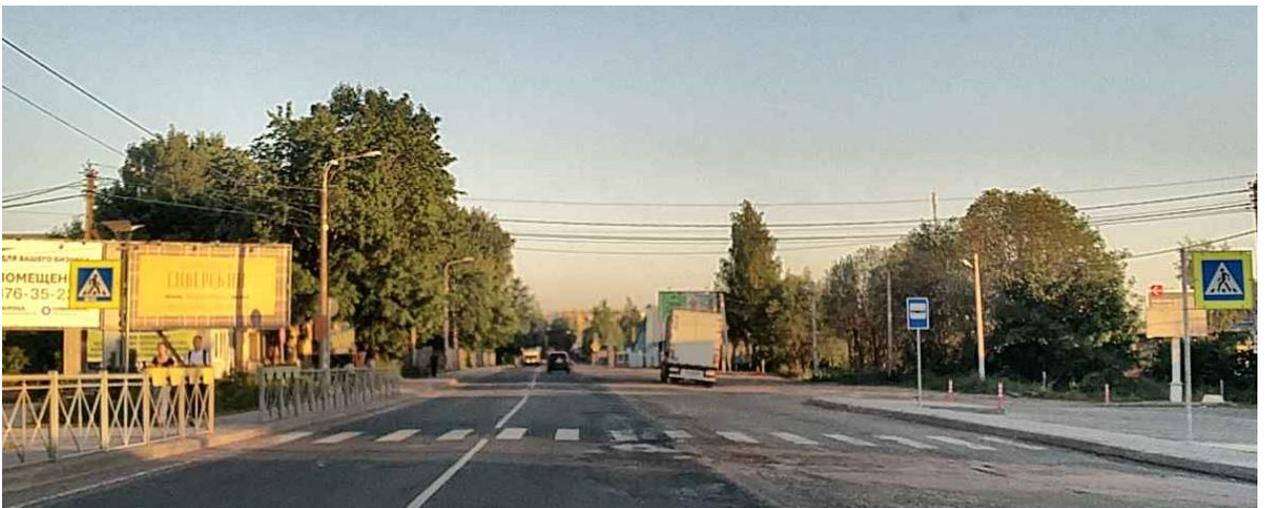
Рисунок 4.3.16.3 – Отсутствие занижения бордюрного камня перед пешеходным переходом в г.п. Сиверский (Заводская ул.)
