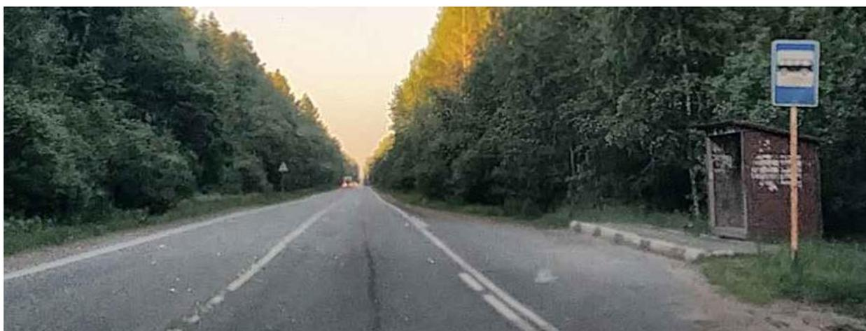
Рисунок 2.6.2.3 – Отсутствует разметка 1.17.1 согласно требованиям ГОСТ Р 52289-2019, а/д 41К-003
