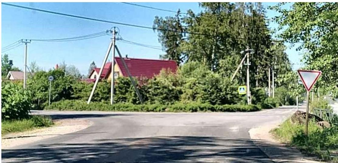
Рисунок 2.6.1.1 – Высота установки знака 2.4 «Уступите дорогу» не соответствует требованиям ГОСТ Р 52289-2019, Сиверское ГП, пересечение Дружносельской ул. и Пролетарского просп.
