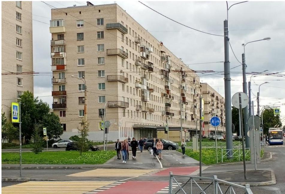
Рисунок 4.3.5.2.13 – Пример организации нерегулируемого пересечения велосипедной дорожки и проезжей части в Санкт-Петербурге
