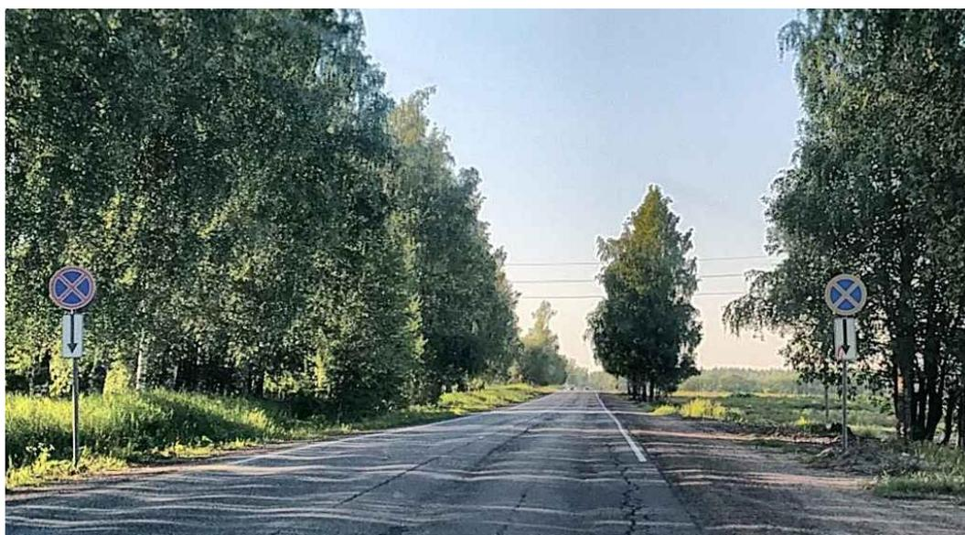
Рисунок 2.6.1.2 – Эксплуатационное состояние знака 3.27 «Остановка запрещена» и 8.2.3 «Зона действия» не соответствует требованиям ГОСТ Р 50597-2017, а/д 41К-100 (пос. Кобринское)
