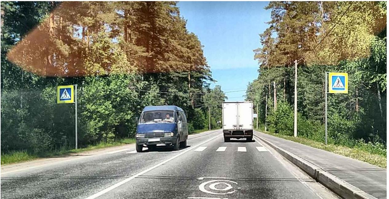
Рисунок 4.3.16.2 – Отсутствие занижения бордюрного камня перед пешеходным переходом в г.п. Вырица (Самарская ул.)
