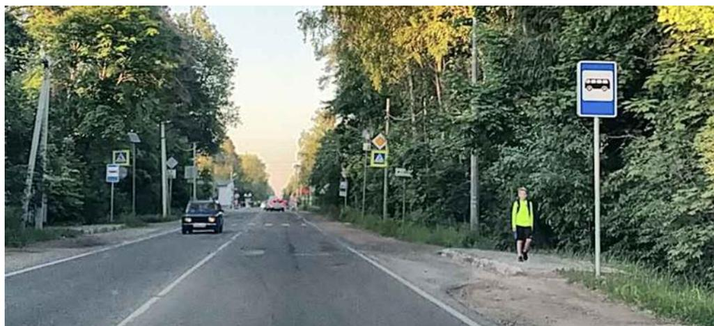
Рисунок 2.4.1.1 – Остановочный пункт в Вырицком ГП (отсутствует автопавильон, дорожная разметка, искусственное освещение)
