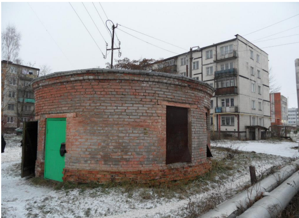
Рисунок 15. Внешний вид здания КНС «Поселковая»
