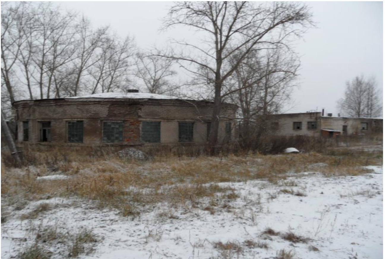
Рисунок 16. Вид канализационных очистных сооружений (КОС)
