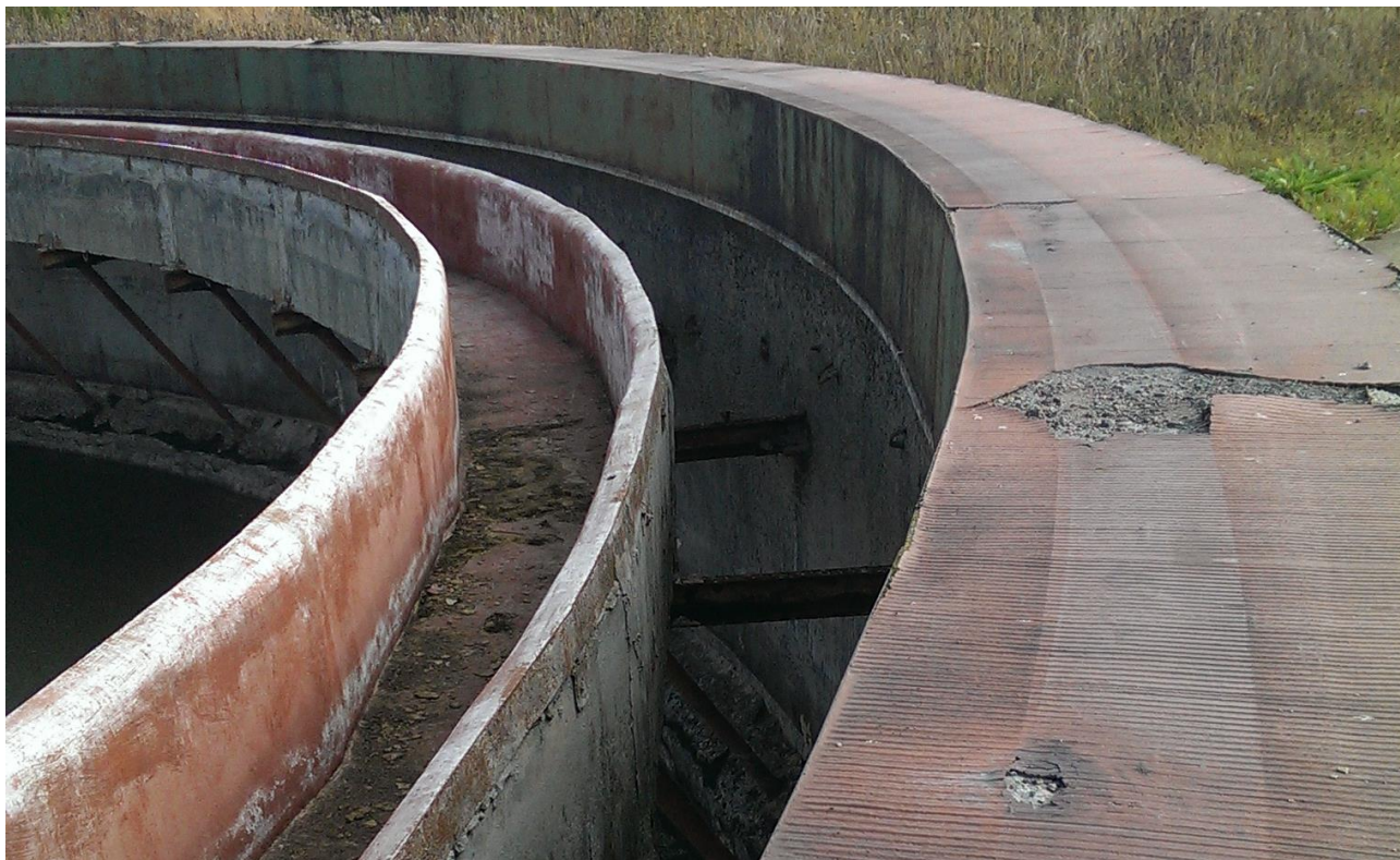
Рисунок 61 - Вид основных несущих элементов конструкции вторичных отстойников
