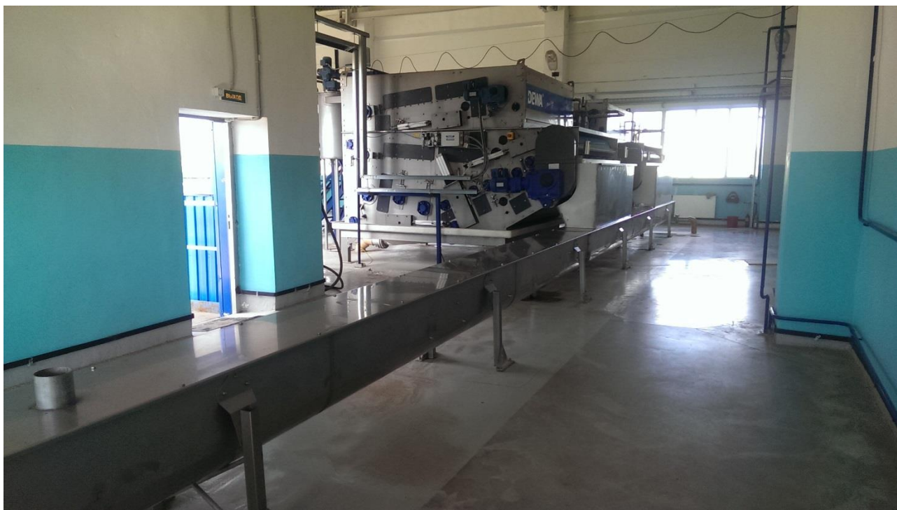
Рисунок 48 - Ленточные пресс-фильтры и шнековый конвейер
