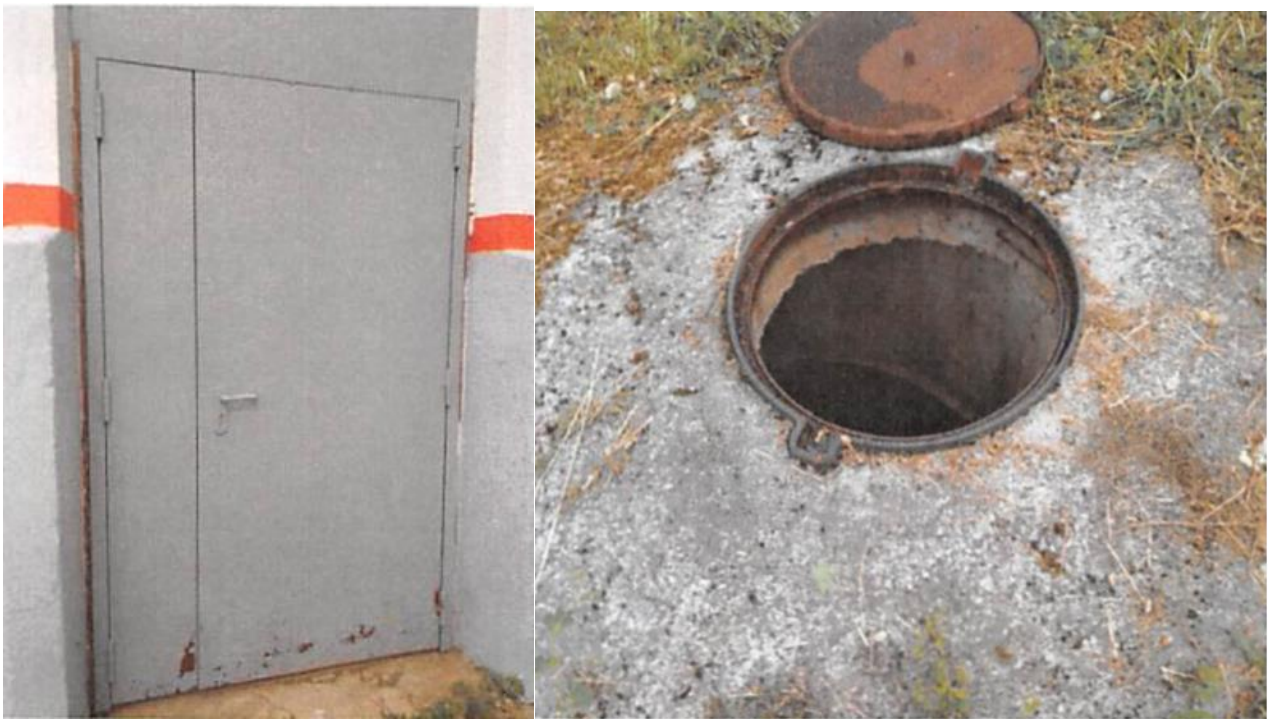
Рисунок 23 - Здание насосной станции над скважиной №2/46 (слева) и колодец скважины №4/82 (справа)
