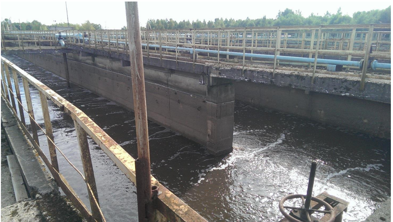
Рисунок 55 - Аэротенк
