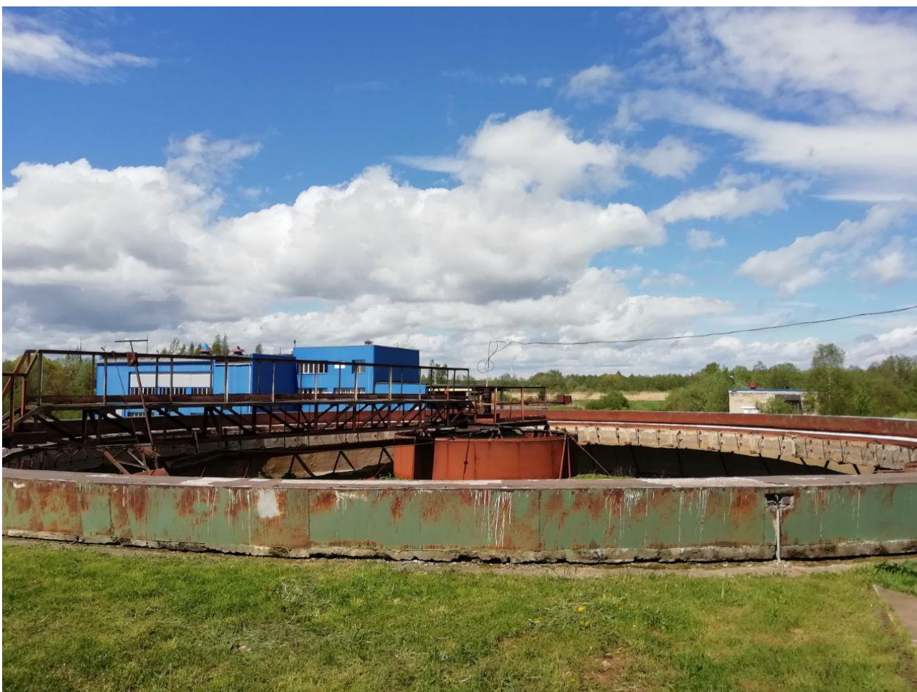
Рисунок 52 - Первичный отстойник (не рабочий)
