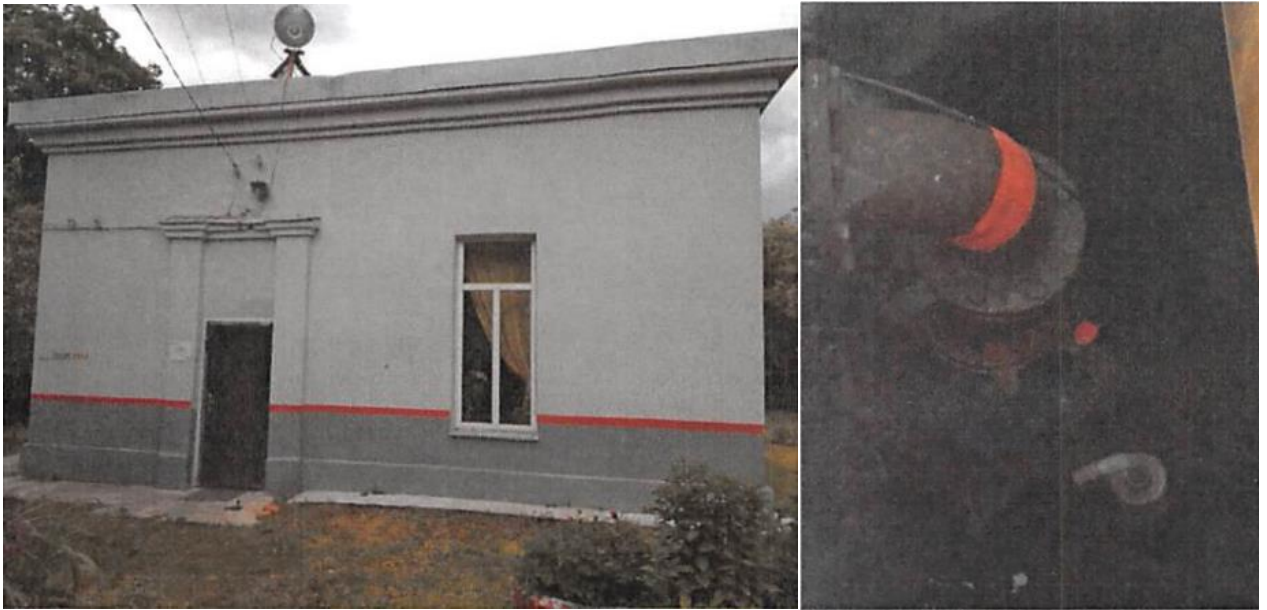
Рисунок 22 - Здание насосной станции (над скважиной) и оголовок скважины №1/46
