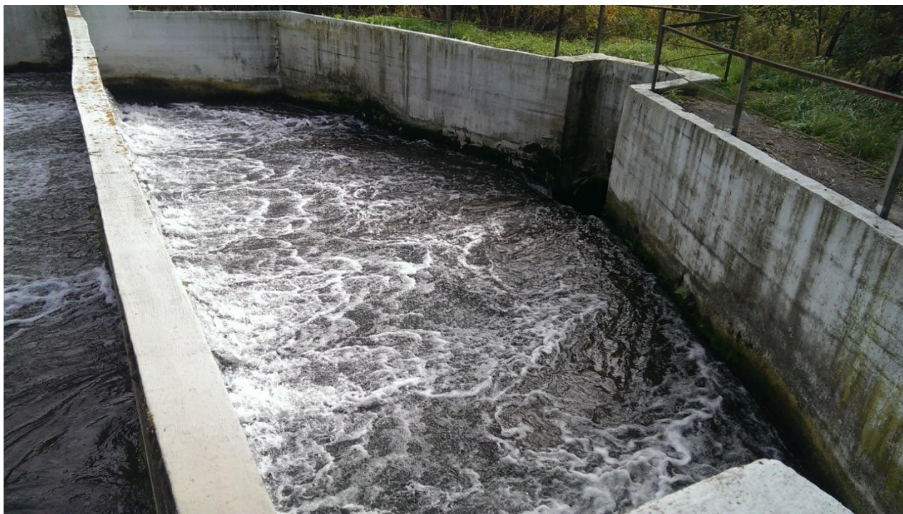
Рисунок 46 - Многоступенчатый водослив-аэратор
