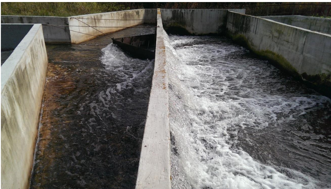
Рисунок 63 - Внешний вид перегородки водослива
