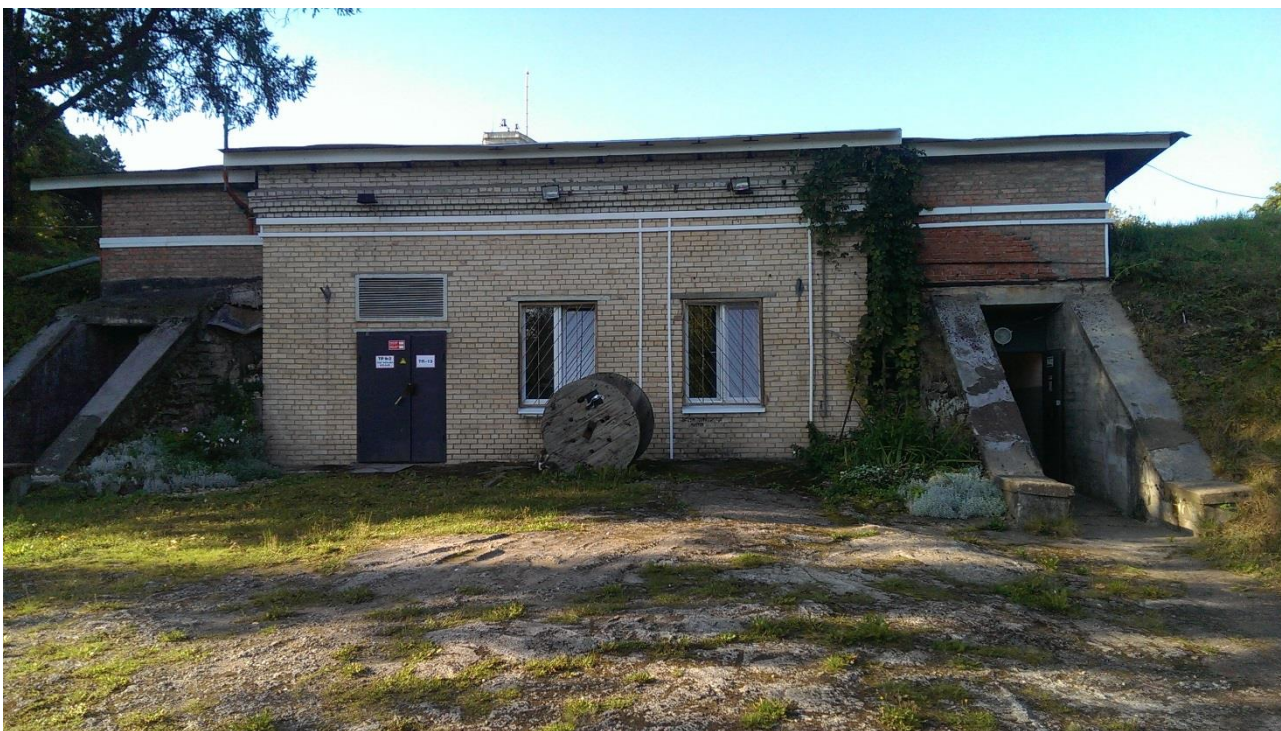
Рисунок 11 - Здание насосной станции оз. «Серебряное»
