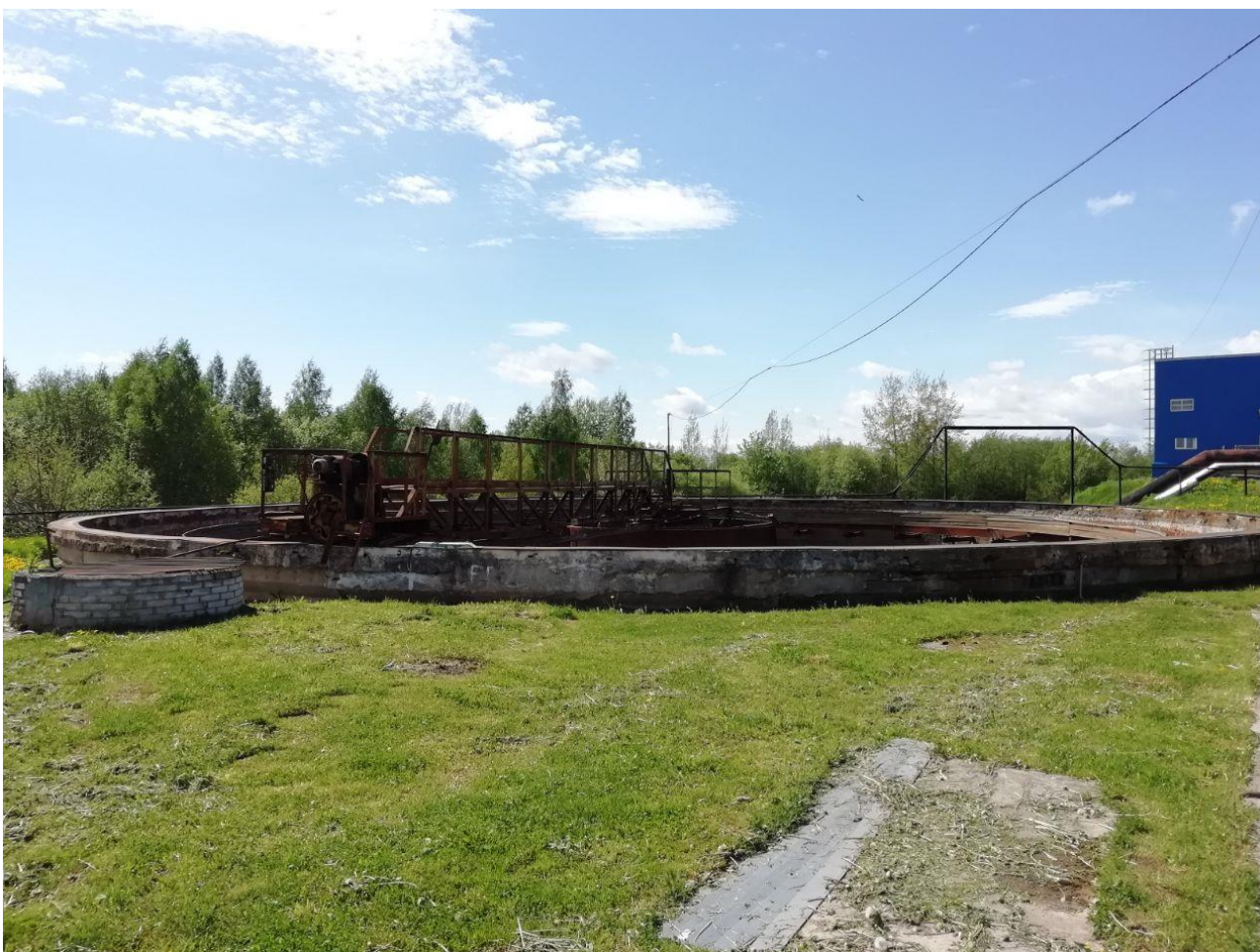
Рисунок 53 - Первичный отстойник (не рабочий)
