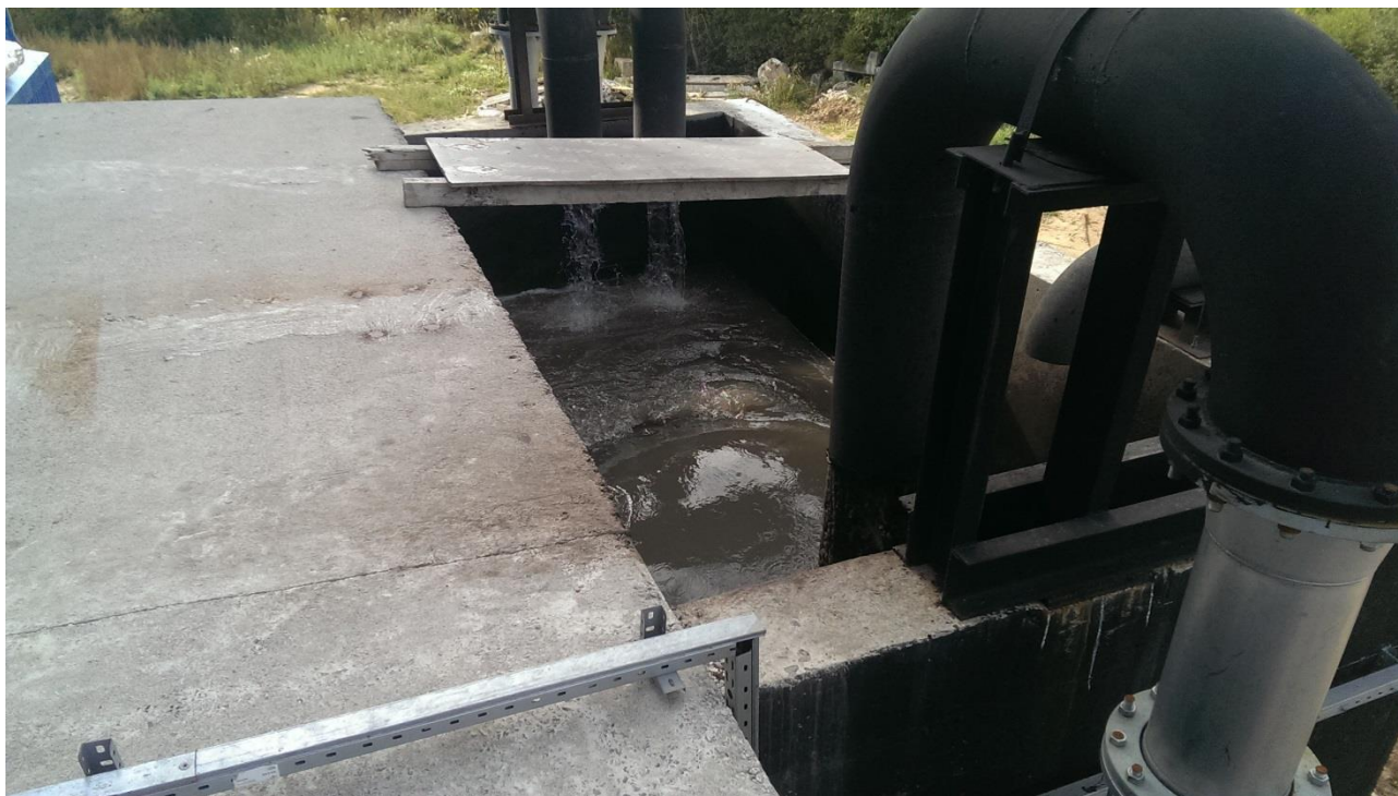
Рисунок 36 - Приемная камера КОС.
