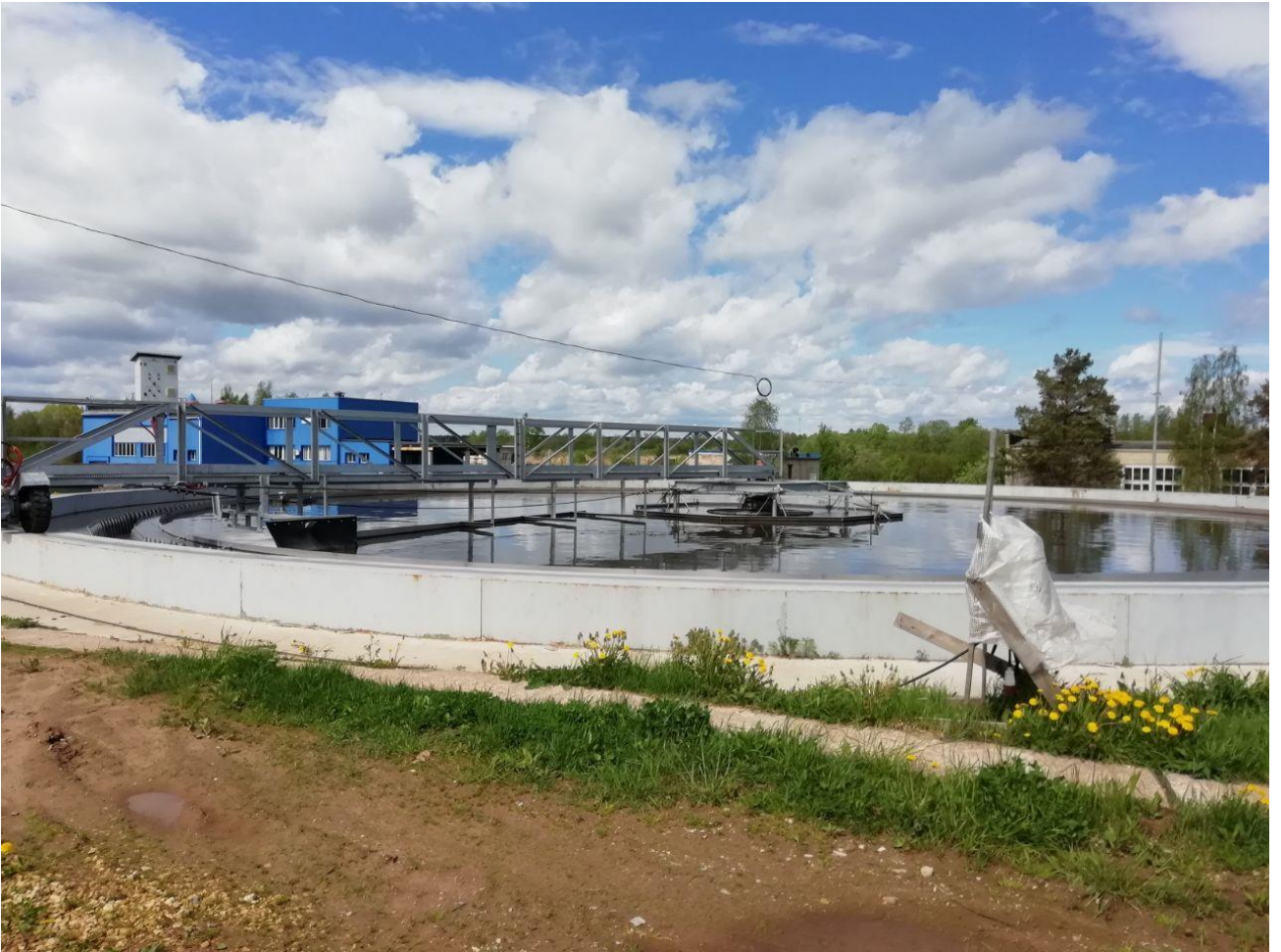
Рисунок 41 - Первичный отстойник (рабочий)
