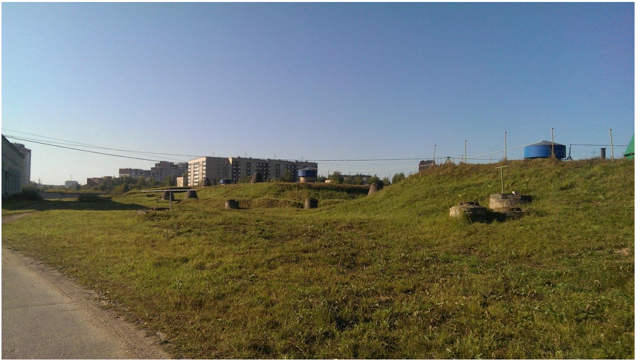
Рисунок 18 - Заглубленные резервуары сырой воды ВНС «Невская» (2 шт. по 10 тыс.м 3 )
