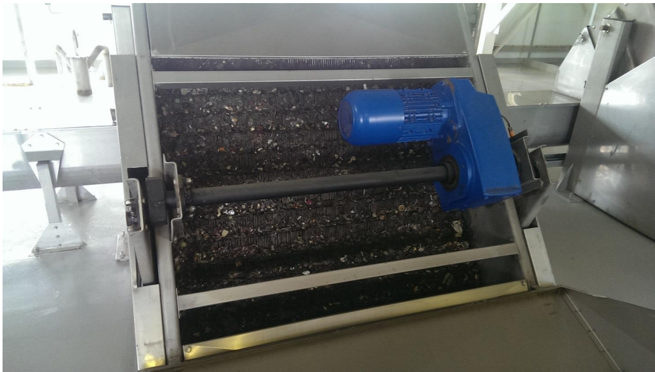
Рисунок 37 - Механизированная ступенчатая решетка с шириной прозоров 3 мм
