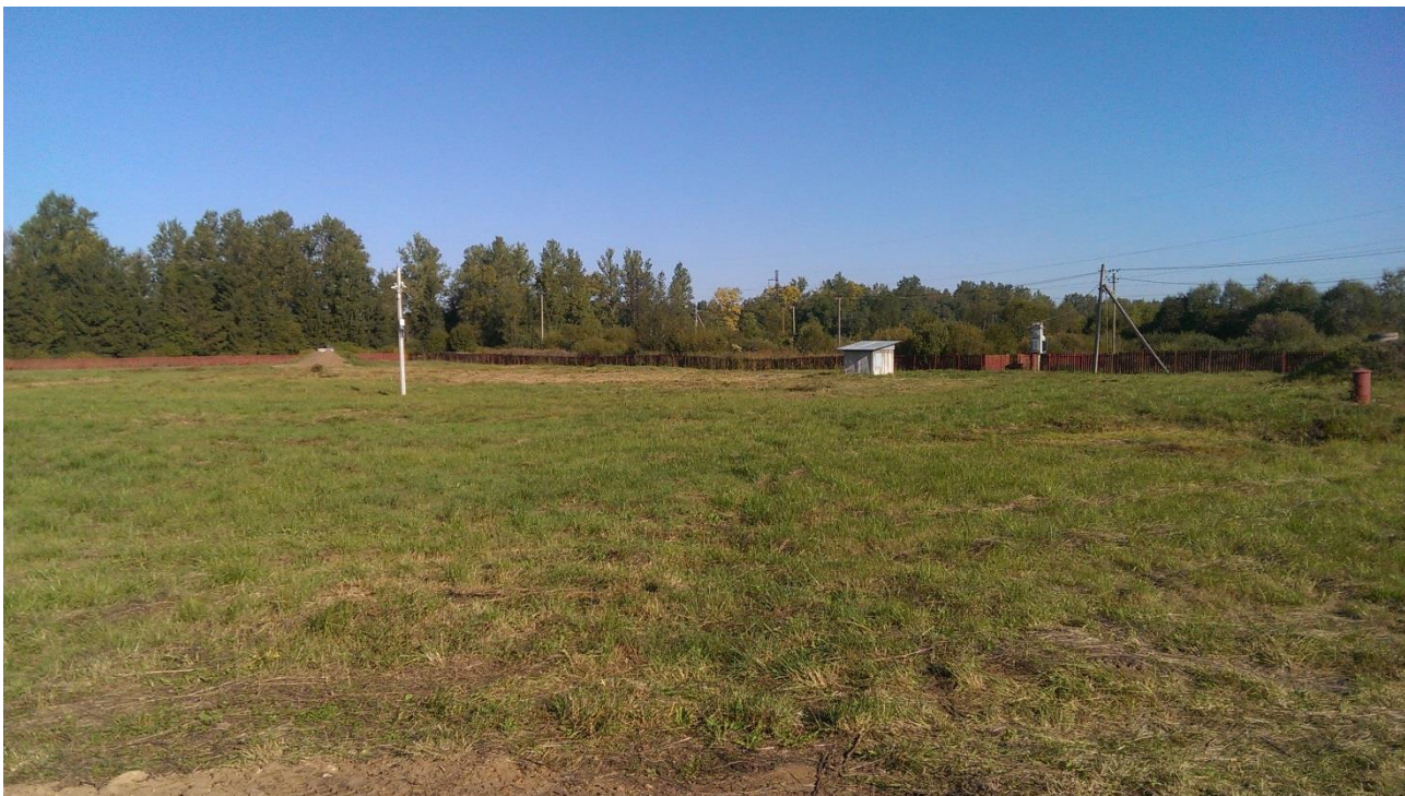
Рисунок 15 - Мачта видеонаблюдения, КТПН и РУ 0,4 кВ водозабора «Северный»
