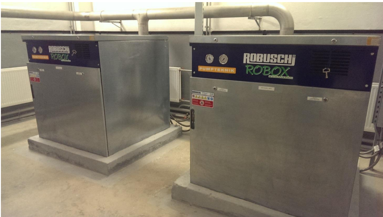
Рисунок 50 - Воздуходувки песколовок
