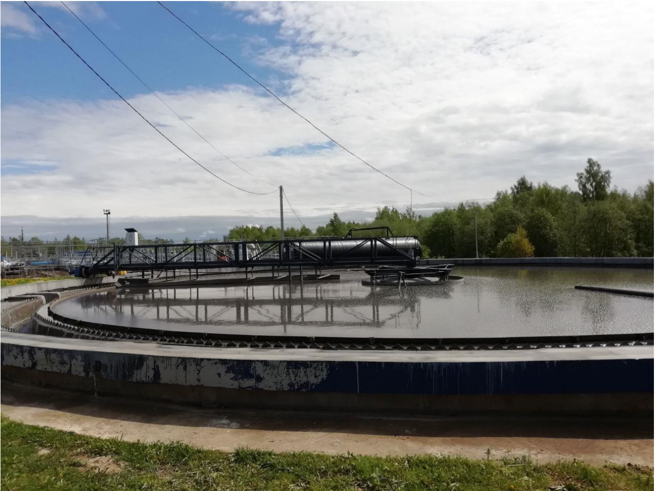
Рисунок 40 - Первичный отстойник (рабочий)
