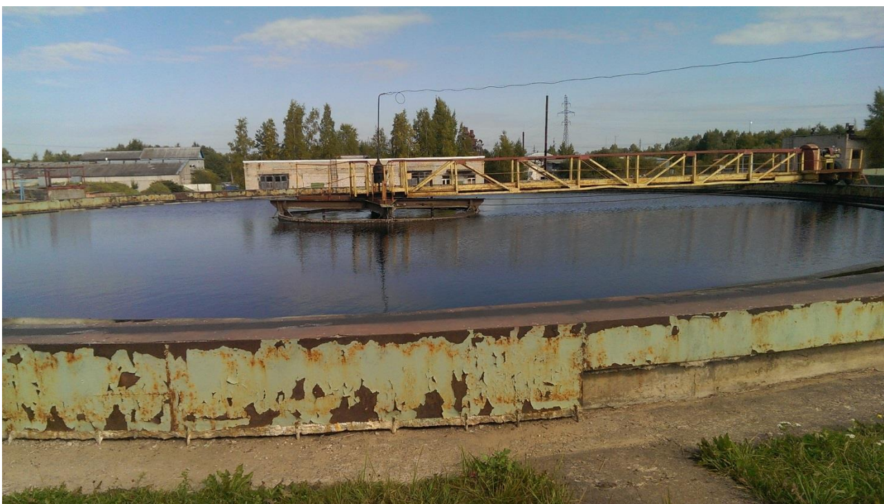
Рисунок 59 - Вторичный отстойник (в работе)
