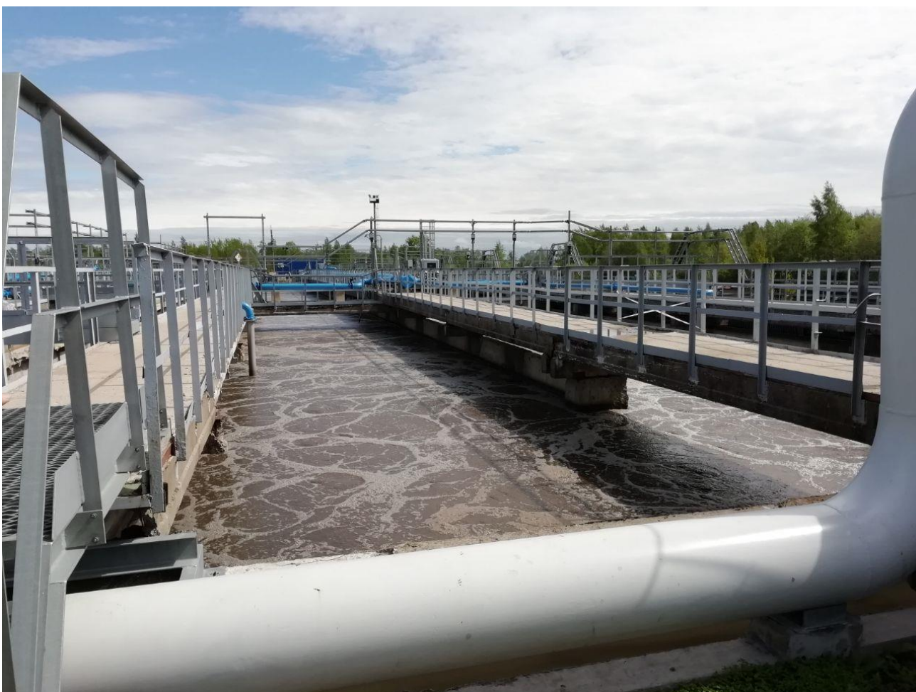
Рисунок 45 - Аэротенк
